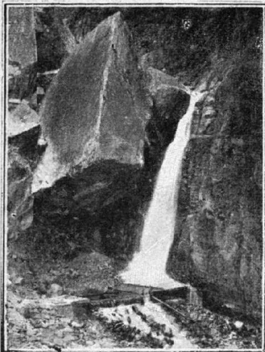
Les travaux du Simplon, vue prise sur le versant italien.
