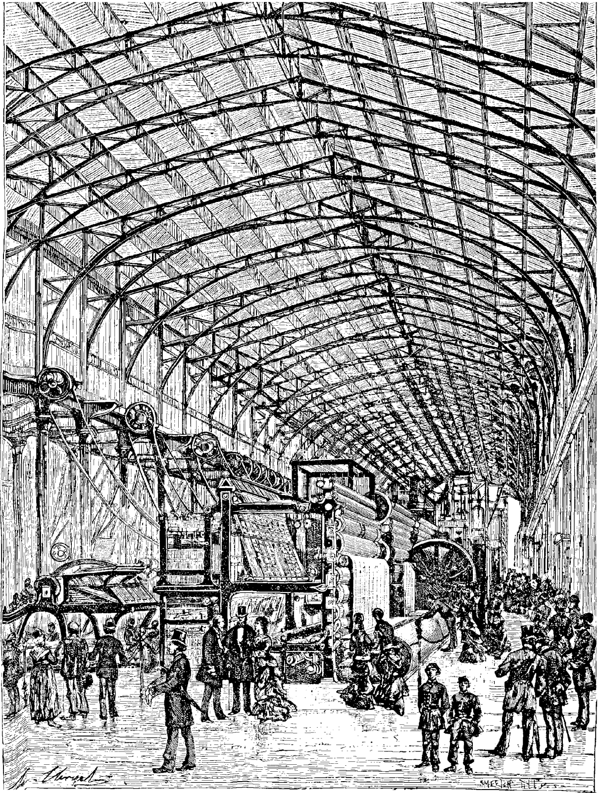
VUE GÉNÉRALE DE LA GALERIE DES MACHINES.
