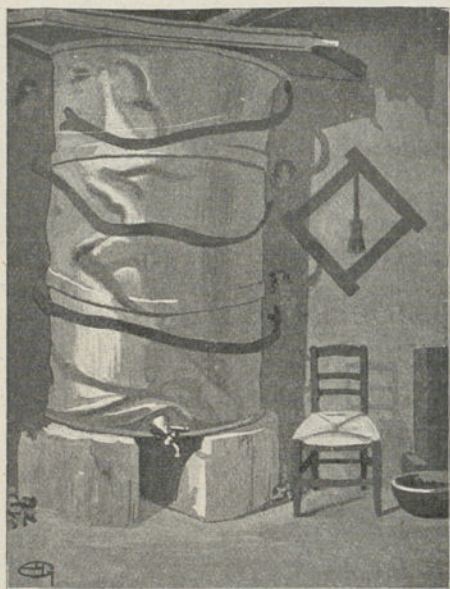
RÉSERVOIR EN TÔLE TORDU PAR UN COUP DE Foudre A PARIS.
