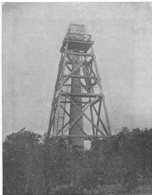
Signal de Saint-Antoine, pylône en briques, construit pour le Service géographique de l'Armée.
