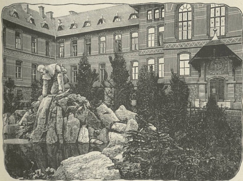
Dans la cour d'honneur de l'hôpital corporatif de Bergmanstrost. — Au fond et à droite, la porte d'entrée. — Au premier plan et à gauche, la statue du mineur, qui vient se désaltérer à la source d'eau vive.
