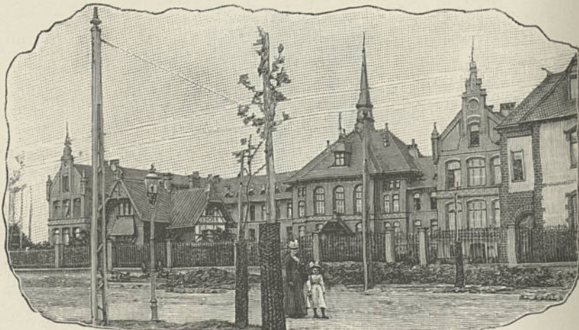
L'hôpital corporatif de Bergmanstrost vu de la grande route. — A droite et au premier plan, l'angle du pavillon des services administratifs et l'habitation de l'inspecteur. — Vers la gauche, le logement du portier jardinier masque l'aile gauche de l'hôpital corporatif.
