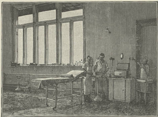
A l'hôpital corporatif de Bergmanstrost. — Dans la salle des opérations aseptiques : la grande fenêtre du côté Sud, avec les stores logés entre les deux parois de verre. Les dispositions prises pour pratiquer la stérilisation des instruments de chirurgie au moyen d'un courant d'électricité dans un bain de bicarbonate de soude.
