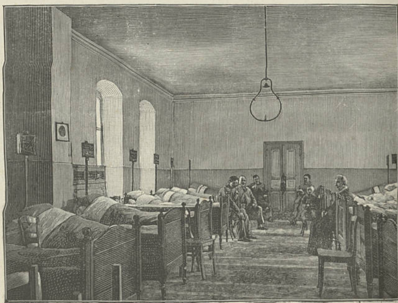
Maison des Frères de Saint-Jean-de-Dieu à Bonn sur le Rhin, 4 Bonnerthalweg.— Une des salles d'hospitalisation du service spécial de Chirurgie des accidents du travail. Il s'y rencontre des ouvriers blessés, qui appartiennent à des Corporations très diverses.
