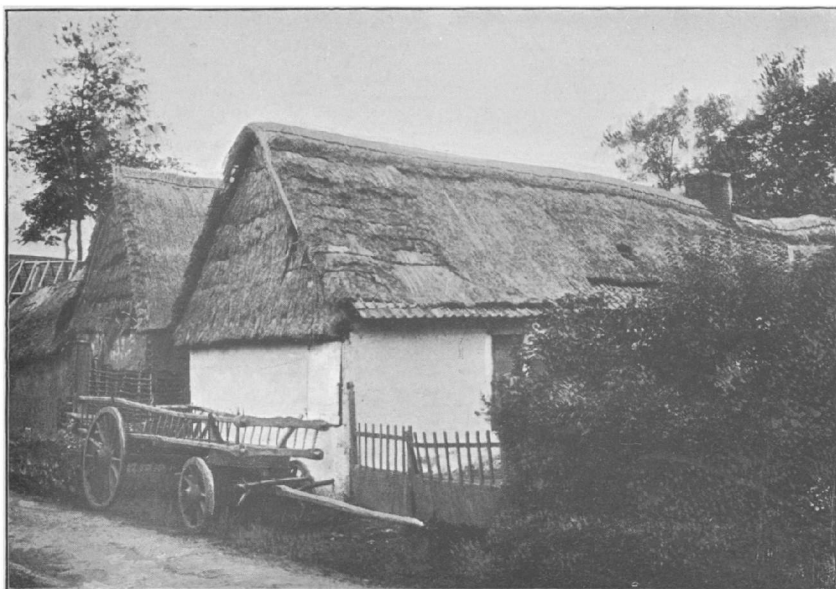
CONSTRUCTIONS RURALES A PRÉDEFIN, PRÈS DE FRUGES Chaume, torchis, lattes.
