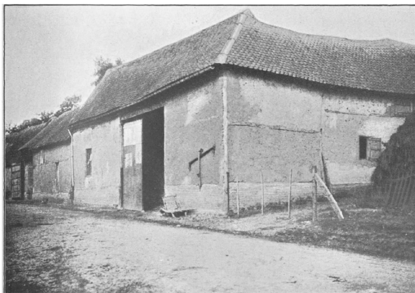
PETITE FERME PICARDE, EN TORCHIS SUR SOLIN DE BRIQUES, A LONGUEVILLE, PRÈS DE DOULLENS
