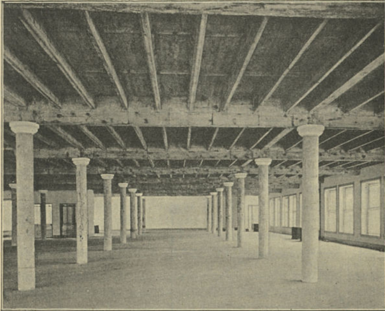
Fig. 194. — Bâtiment commercial à Milwaukee. Vue intérieure.
