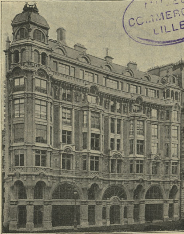
Fig. 275. — Maison, rue Danton, à Paris. Façade.
