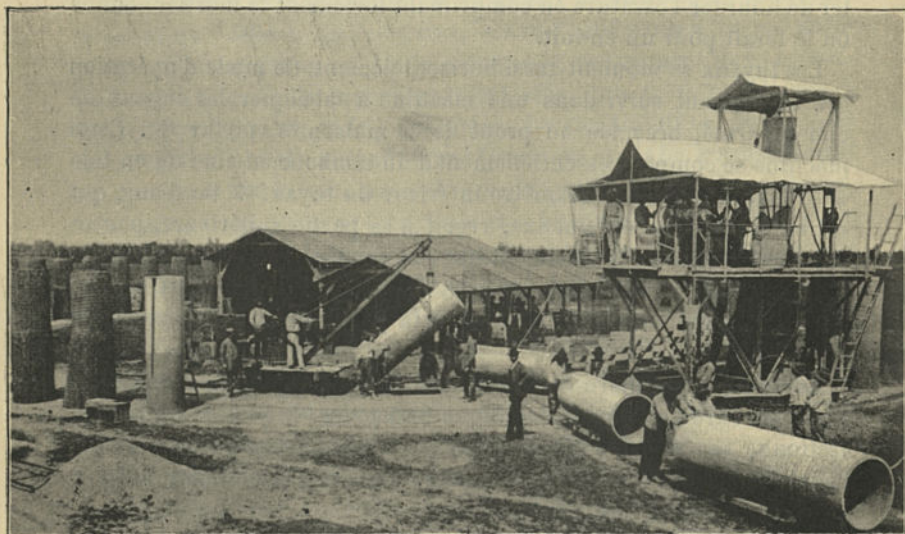
Fig. 777. — Vue d'un chantier de fabrication de tuyaux en sidéro-ciment.
