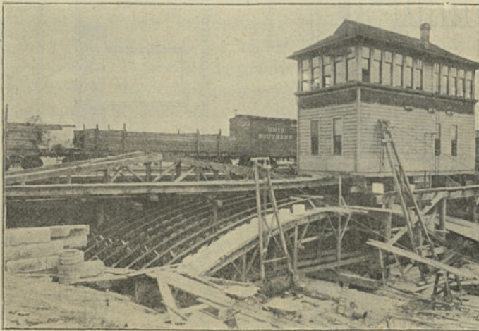
Fig. 444. — Vue de l'ouvrage en exécution.
