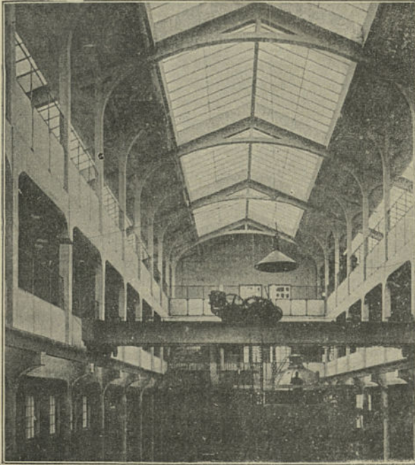
Fig. 37). — Établissements Sautter-Harlé et C ie , rue de la Fédération, à Paris. Atelier de la mécanique générale.
