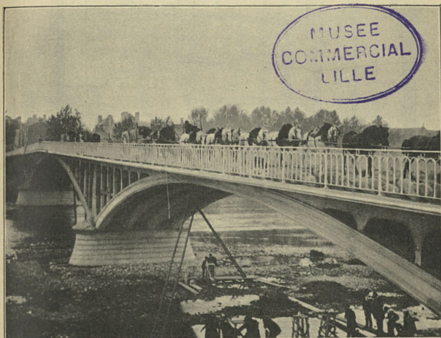
Fig. 503. — Pont sur la Vienne à Châtellerault (1899).
