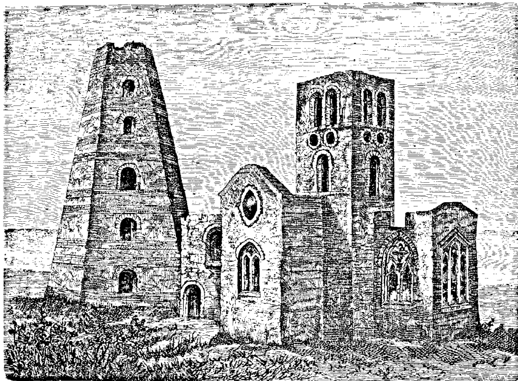
Fig. 270. — Phare de Douvres, supposé de construction romaine ; et tour carrée du château de Douvres.
