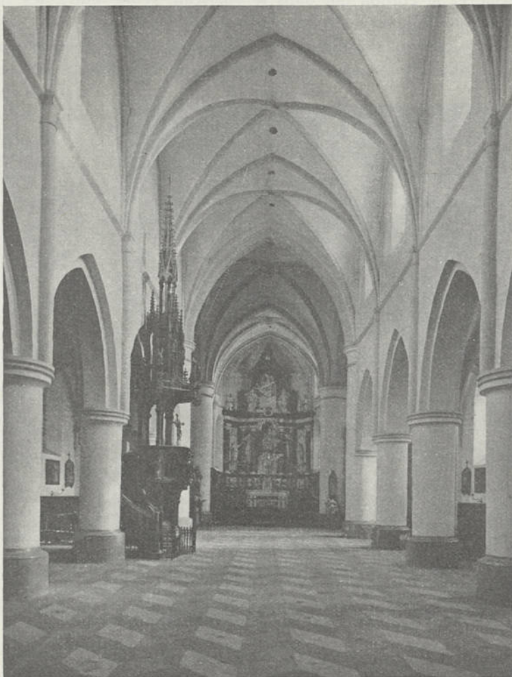
Fig. 90. Diest, Eglise Notre-Dame, vue intérieure de la nef centrale et du chœur
