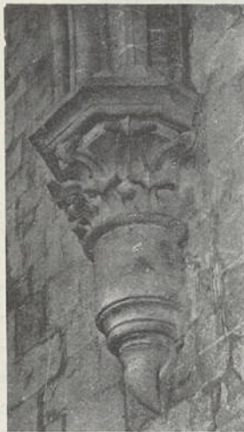
Fig. 210. Léau, Collégiale Saint-Léonard, support de voûte dans le croisillon nord
