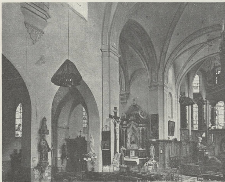
Fig. 225. Jodoigne, Eglise Saint-Médard, vue intérieure, vers le chœur 220
