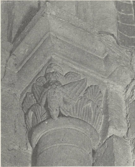
Fig. 194. Hakendover, Eglise Saint-Sauveur, chapiteau de la croisée
