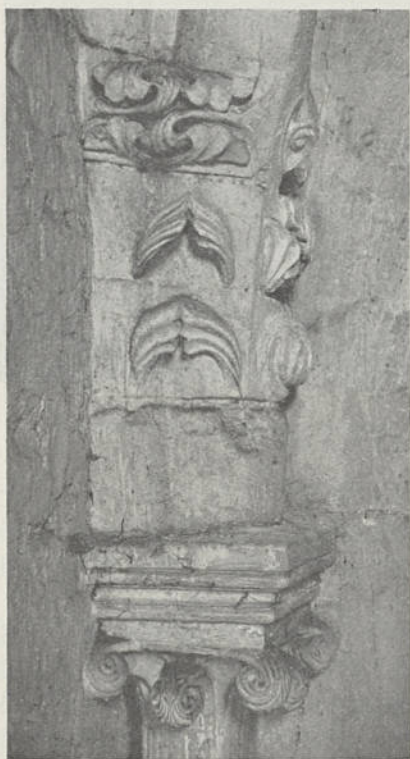
Fig. 3. Louvain, Eglise Saint-Jacques, tas-de-charge sous la voûte du clocher
