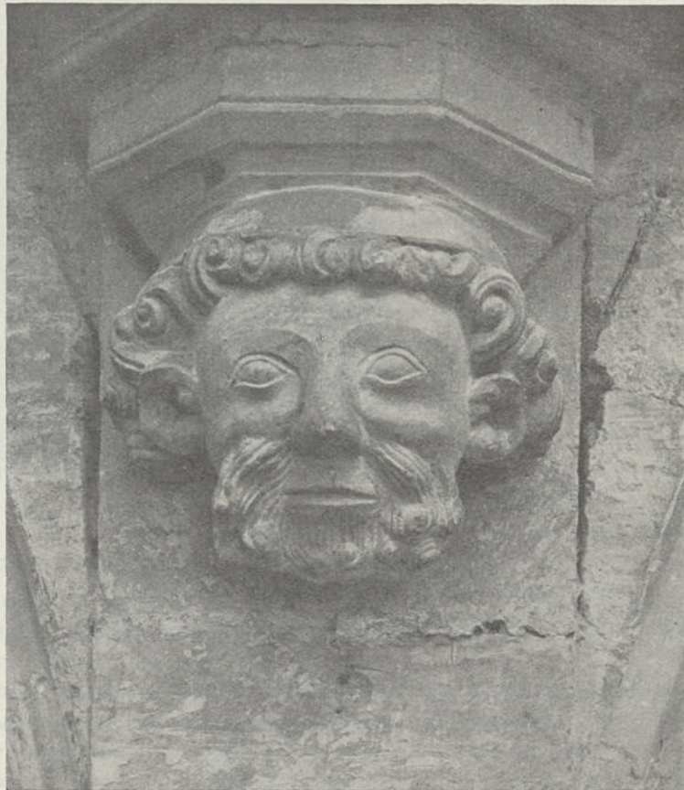
Fig. 9. Louvain, Eglise Saint-Jacques, console soutenant les supports de la voûte dans la nef centrale
