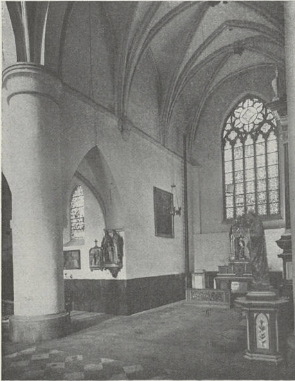
Fig. 91. Diest, Eglise Notre-Dame, vue intérieure du croisillon nord
