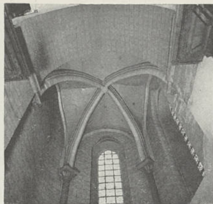
Fig. 224. Jodoigne, Eglise Saint-Médard voûte des absidioles du transept
