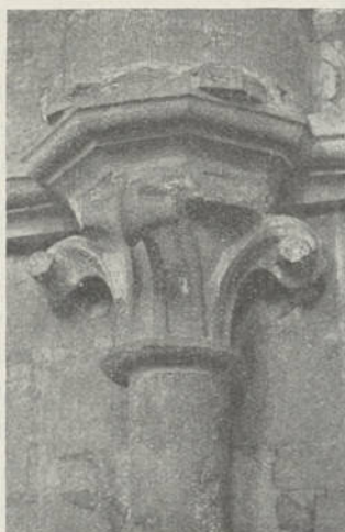
Fig. 215. Chapiteau recevant la retombée des voûtes, dans la nef
