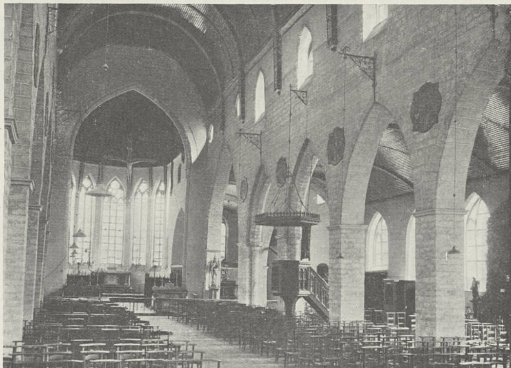
Fig. 149. Tirlumont, Eglise du Béguinage, vue intérieure vers l'est
