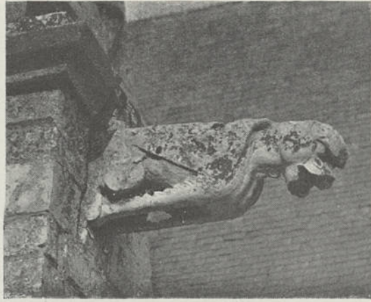
Fig. 181. Oplinter, Eglise Sainte-Geneviève, gargouille du bas côté sud
