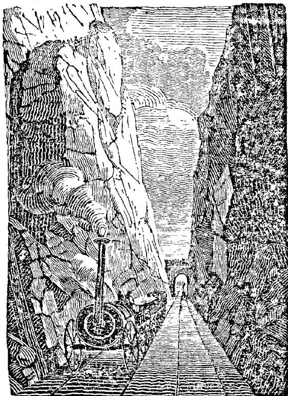
Excavation du Mont-Olive.
