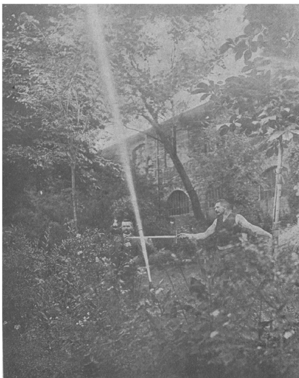
FIGURE 4. — Expérience du jet d'eau de Lancey (Isère).
