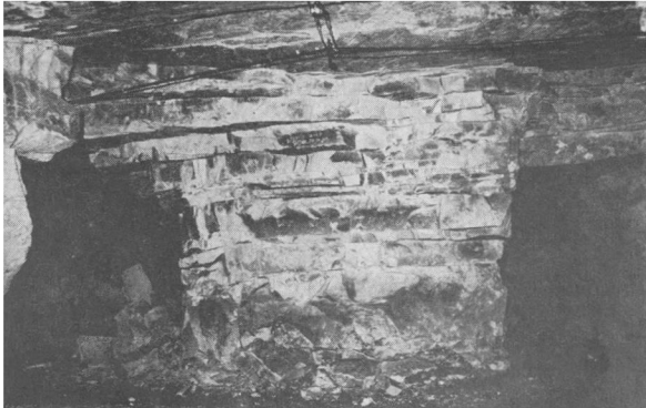
Fig. 2. — Exemple de pilier dans une carrière souterraine (Cambrai, Nord).
