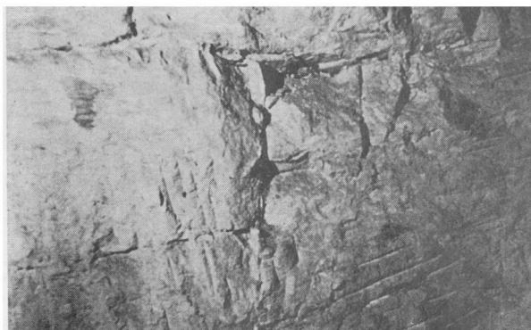
Fig. 8. — Exemple de relevé photographique permettant de suivre l'évolution de l'écaillage.
