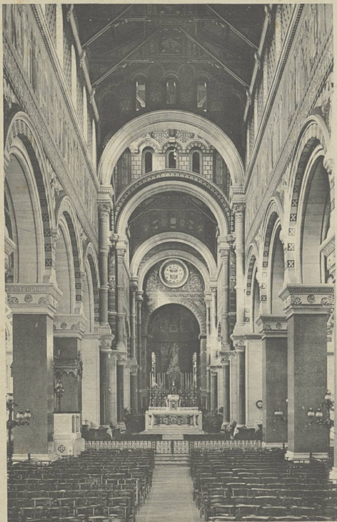
Vue générale intérieure prise d'en bas.
