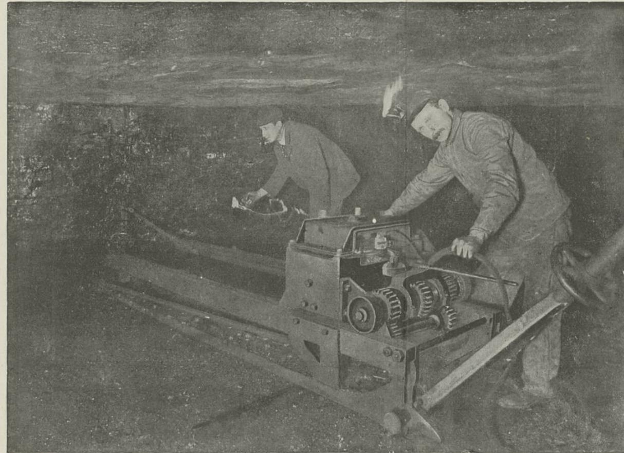
FIG. 29. — Machine Morgan-Gardner, en chantier.
