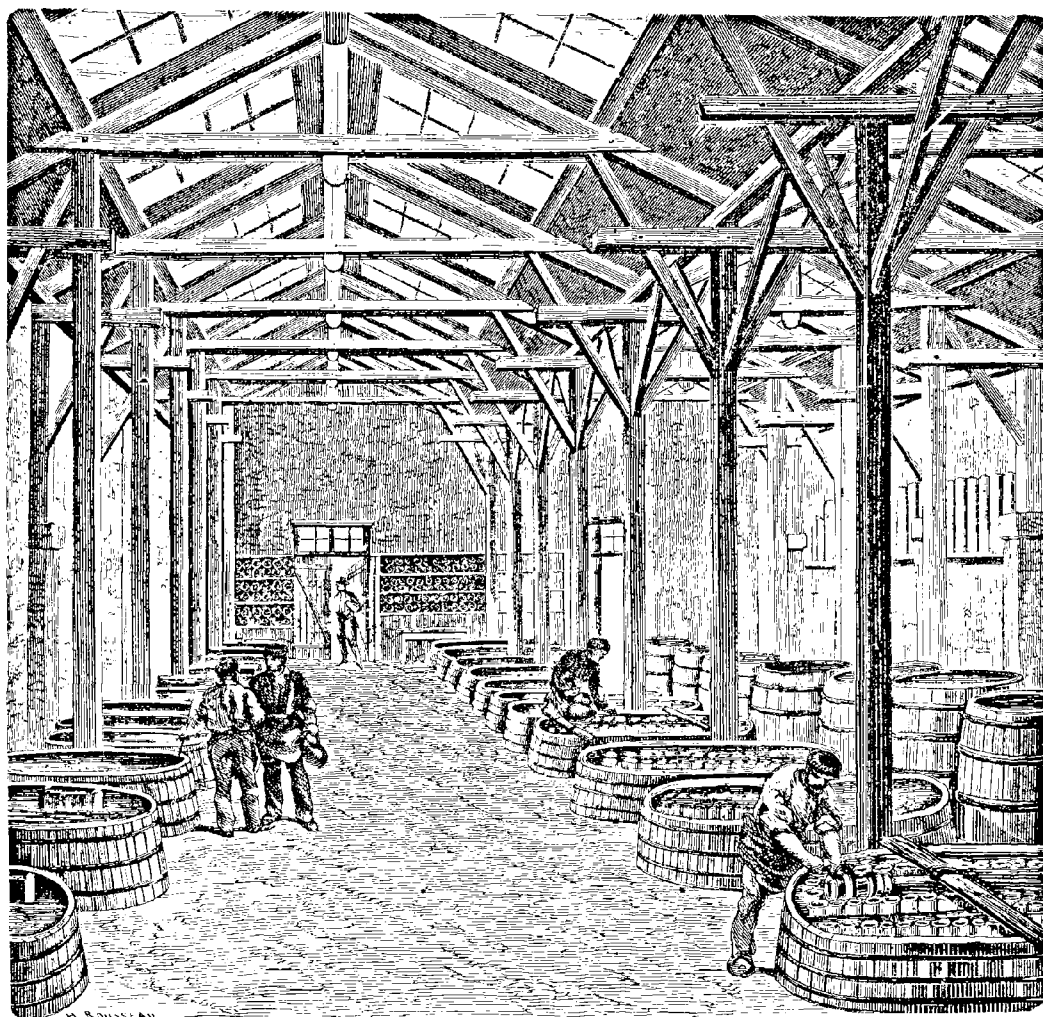
Fig. 234. — Atelier des bains pour le cuivrage électro-chimique de la fonte et du fer, dans l'usine électro-métallurgique de M. Oudry (page 379).
