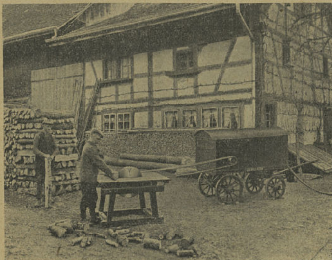
Scie circulaire commandée par un grand chariot à moteur.
