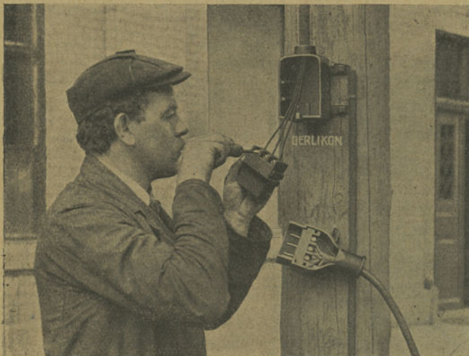
Raccordement de la canalisation d'amenée et du câble à la boîte de prise K D 41.
