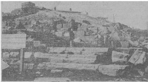
SOMMET DU PUY DE DÔME ET RUINE D'UN ANCIEN TEMPLE.
