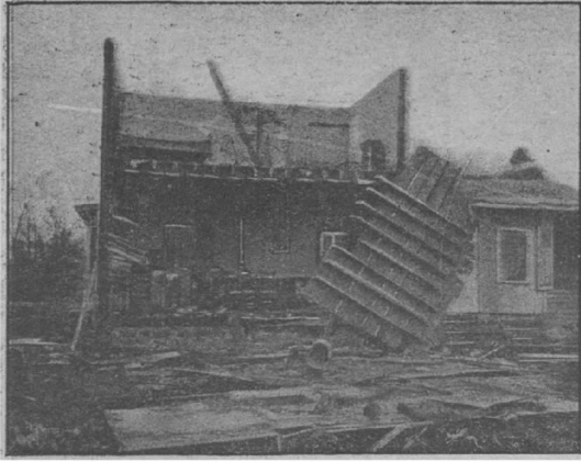
Cette photographie prise en Amérique, donne une idée de la violence des cyclones qui enlèvent des toitures et éventrent les habitations.
