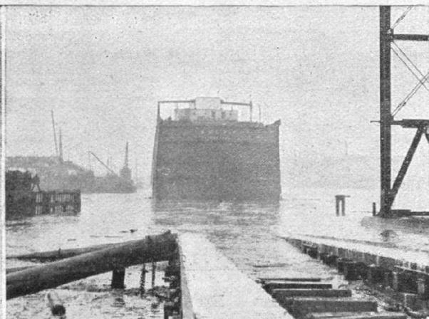
LANCEMENT DE LA MOITIÉ D'UN VAISSEAU. — On sait que le *Suevic* par suite d'un abordage était rentré au port coupé en deux; on vient de le réparer et le lancement s'est exécuté en deux temps, d'abord l'avant, puis l'arrière, neuf, qui est venu s'accoler à la partie ancienne.
