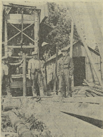
Les Pétroles de Birlenbach. — Le puits foncé à Birlenbach, au point choisi par Henri Mager, a atteint un premier niveau pétrolifère à 164 mètres de profondeur.
