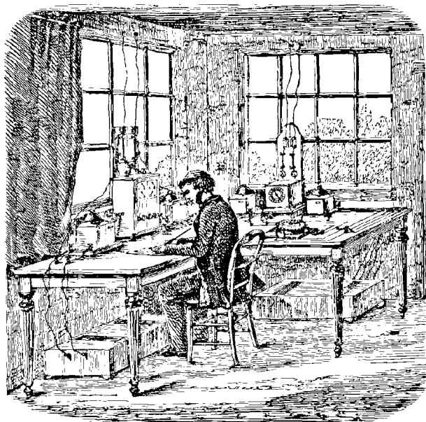
Fig. 289 Vue intérieure d'un poste de télégraphie électrique sur un chemin de fer.
