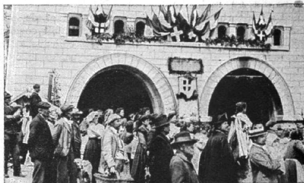
Les fêtes de l'inauguration du Simplon, du 28 mai au 1 er juin. (Devant le tunnel d'Iselle)
