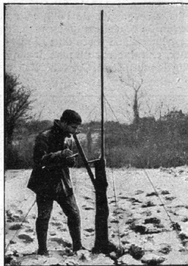
Appareil très simple pour savoir exactement d'où vient le vent.
