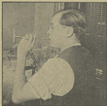
Comment on souffle les ampoules radiogènes.
