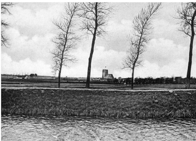
31. — Type de village de la Plaine (Oostkerke, près Bruges). La tour, ancien phare du Zwin.
