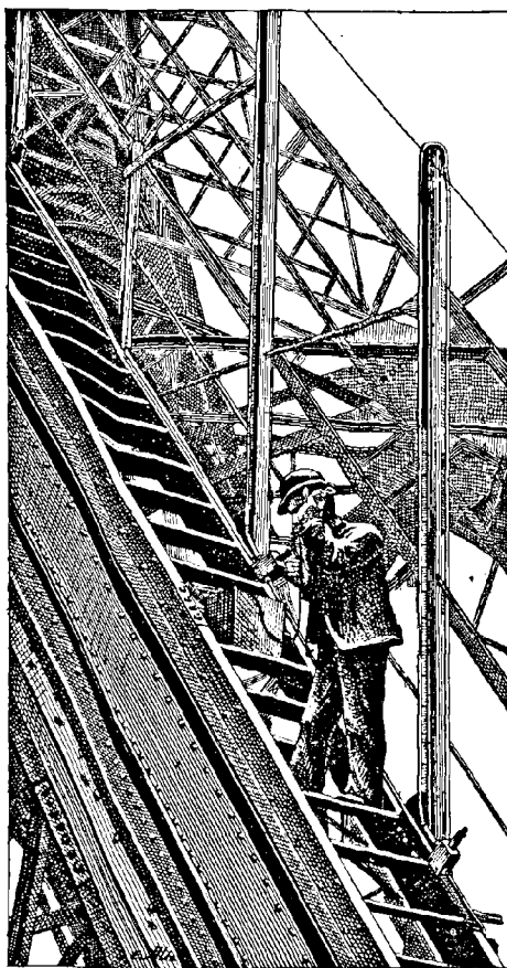
Fig. 6. — Détail d'installation d'un robinet et d'un tube en verre.
