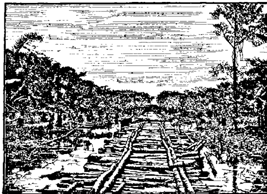
Établissement d'une ligne de chemin de fer dans une plaine marécageuse.
