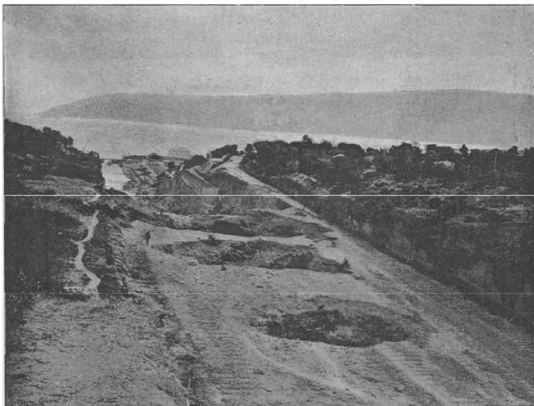
Fig. 4. — Vue du même chantier après les jonctions des entonnoirs.
