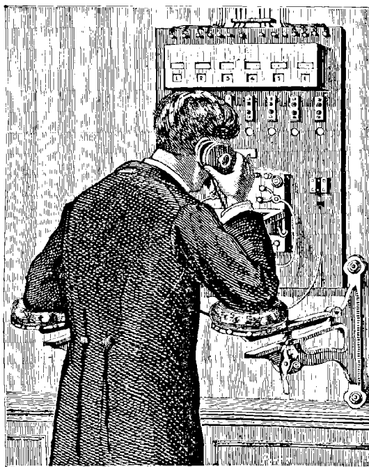
Fig. 125. — Poste d'abonné formant petit bureau central auxiliaire.
