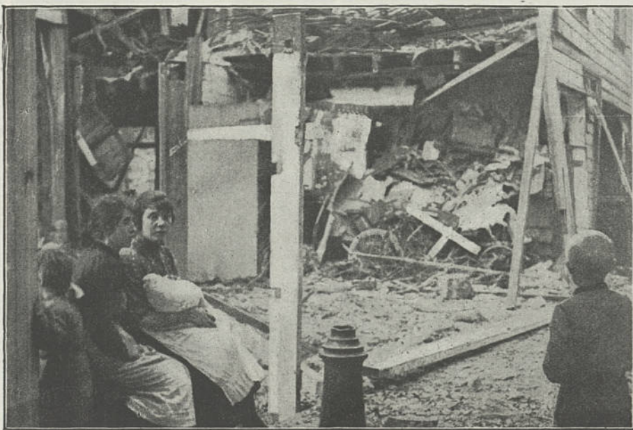
Au seuil d'une maison détruite (Avenue Thiers à Rosendaël)
