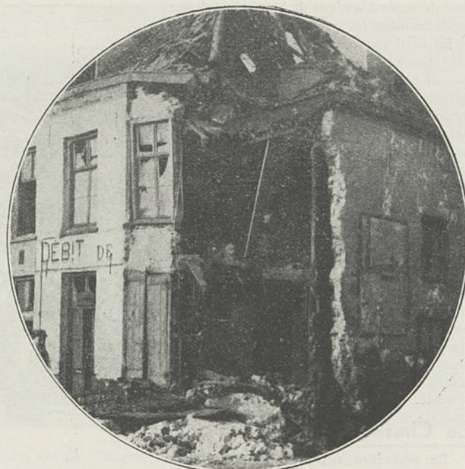
Débit de tabacs éventré par une torpille tombée sur le trottoir, à l'angle de la rue du Rempart et du quai de la Citadelle (29-30 Janvier 1918).
