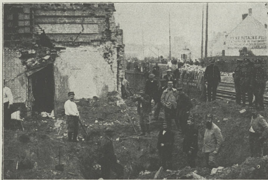
Rosendaël. — Entonnoir sur l'emplacement de la maison de la garde-barrière qui eut ses trois enfants tués sous ses yeux (12 Septembre 1917).
