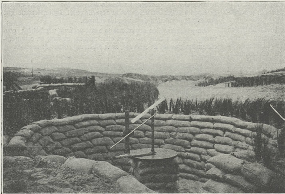
Blindage de sacs à terre autour d'un poste d'observation à la batterie de Malo-Centre (1917)
