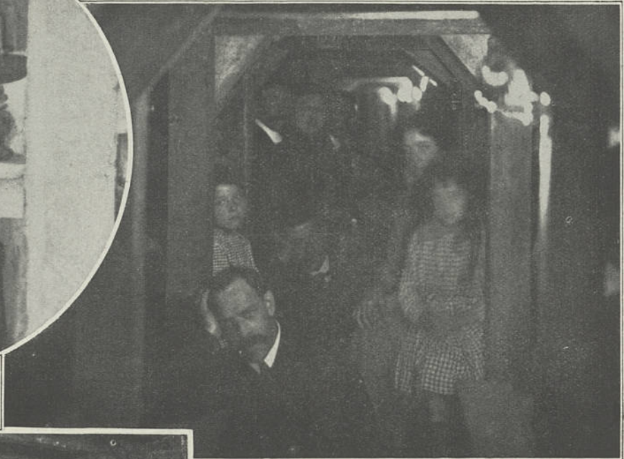
L'intérieur d'une galerie souterraine
