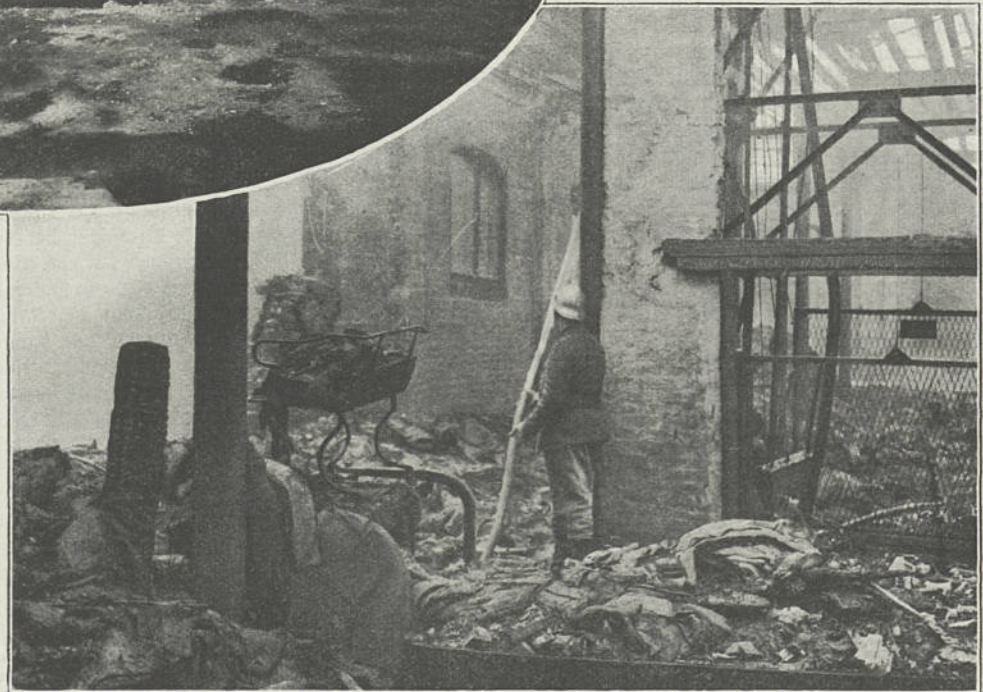
A gauche : Brèche ouverte par une torpille dans un plancher en ciment armé à l'Entrepôt des Laines.
