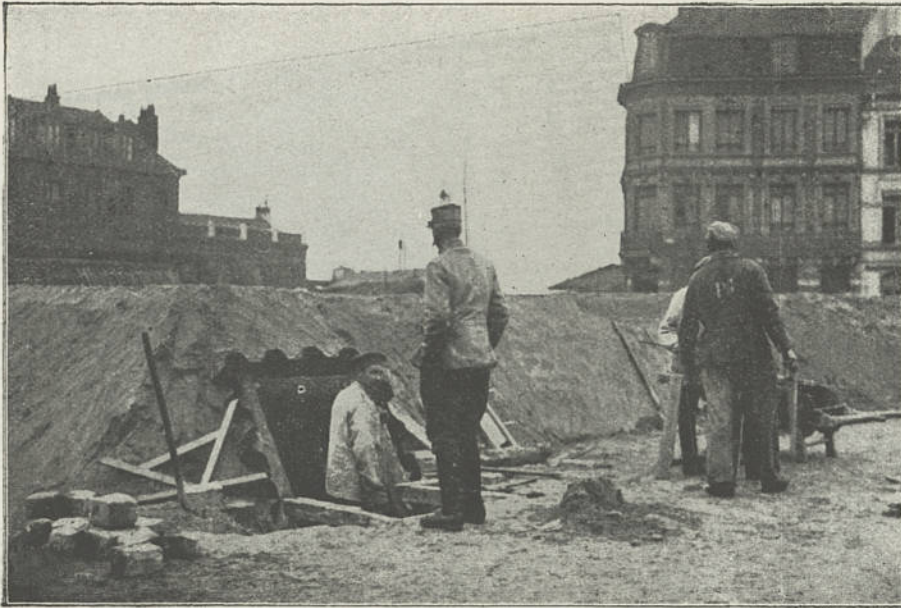
Construction de l'abri bétonné sous la Place de la Gare (Octobre 1917)
