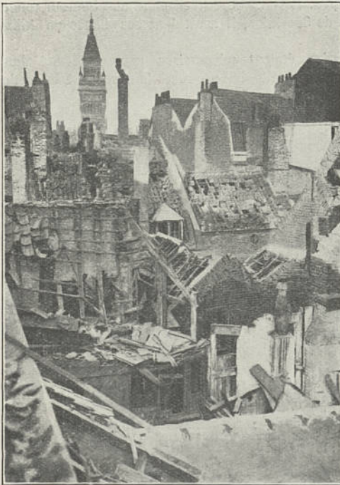
Groupe de maisons entre la rue de la Maurienne et la rue des Bassins, après l'explosion d'une torpille.
