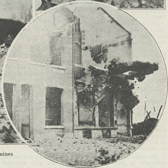
Dans le médaillon : L'effondrement d'une façade sous l'explosion d'une torpille
