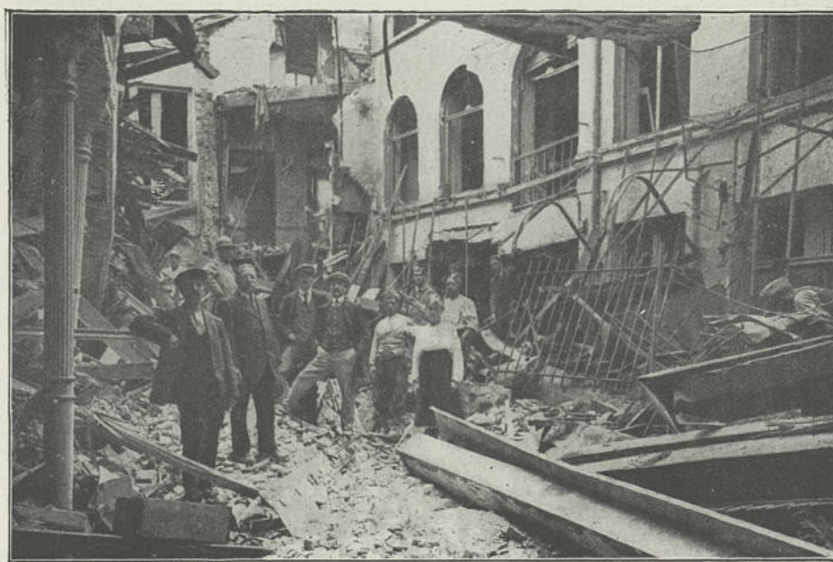
Rue de l'Eglise. — Le "Comptoir d'Escompte" (nuit du 25/26 Juillet 1916)
