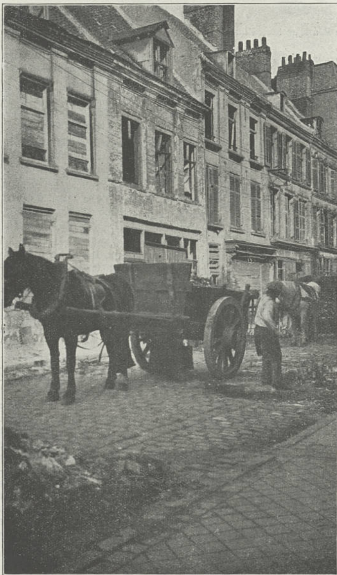
Rue Sainte-Barbe. — Les Services Municipaux procèdent sans retard à l'enlèvement des décombres des maisons bombardées.
