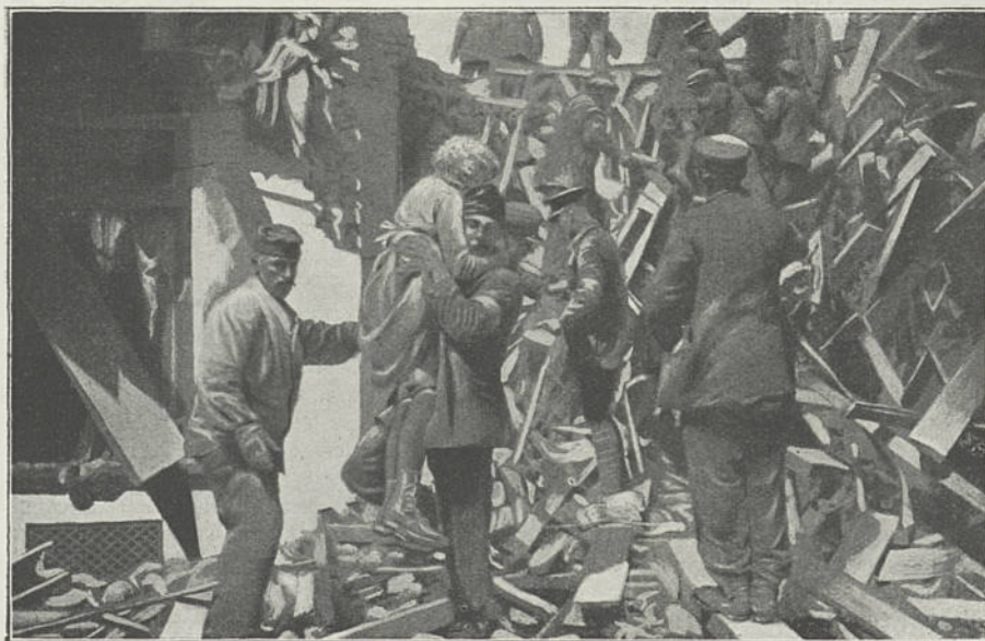
Sauvetage de deux jeunes filles dans les décombres d'une maison écroulée
