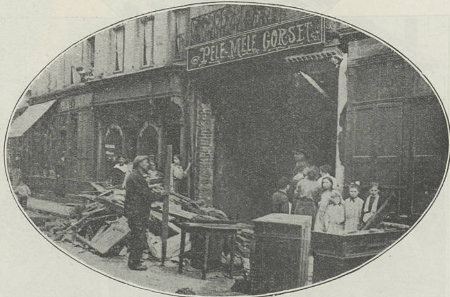
Bombardement du 10 Septembre 1917. — Où l'on voit le magasin du "Pèle-Mêle" rue de la Couronne N° 8. mériter son titre d'une façon imprévue
