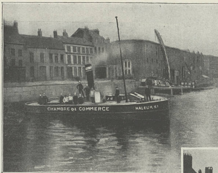
Bateau-pompe sous pression
