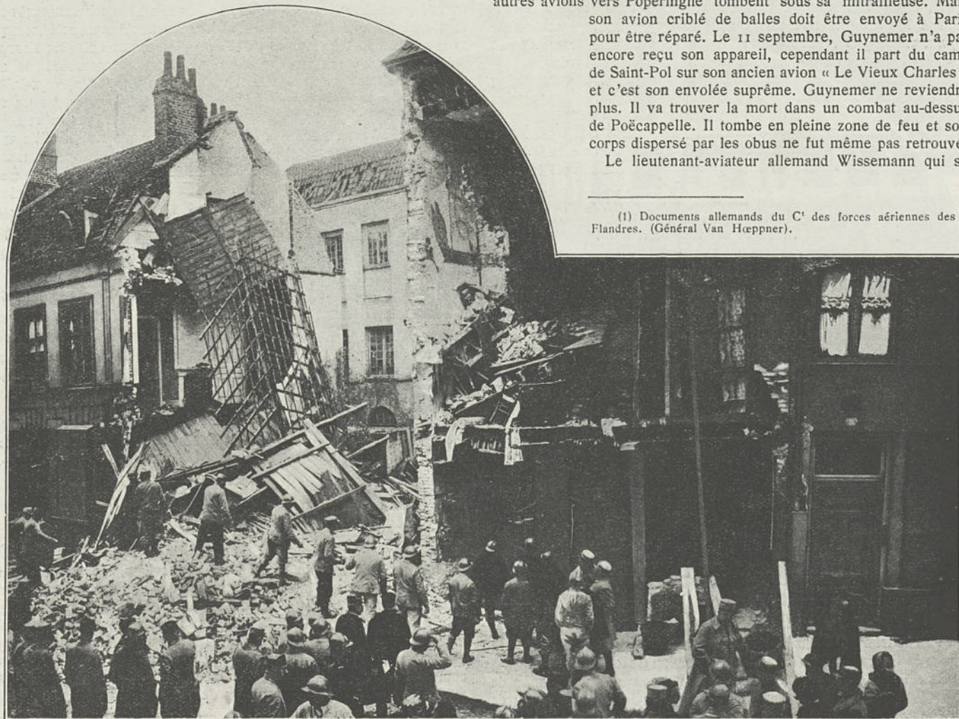
La catastrophe de la rue Caumartin. Les immeubles N° 10 et 12. C'est dans la cave du N° 10 que 35 personnes trouvèrent la mort
