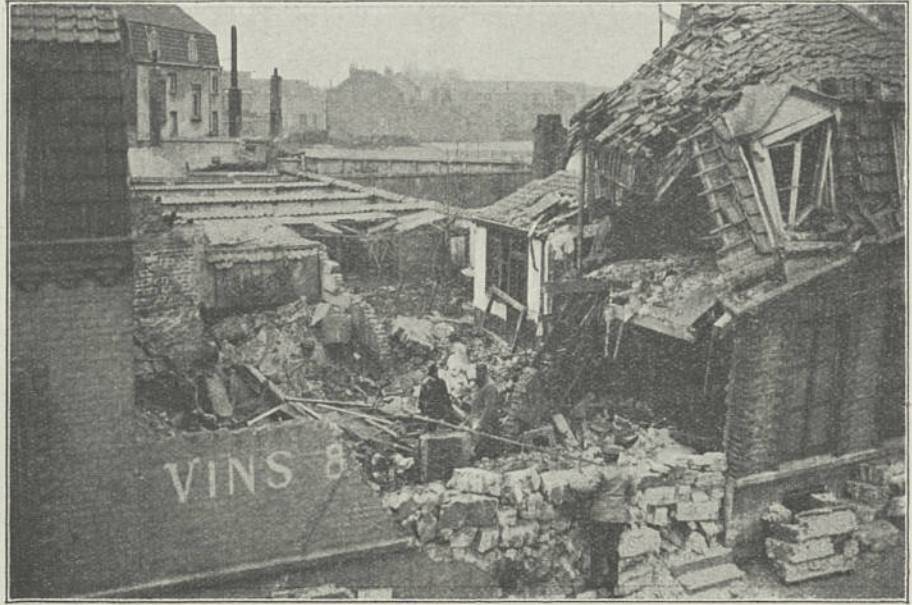
Immeuble détruit rue Voltaire, à Rosendaël
