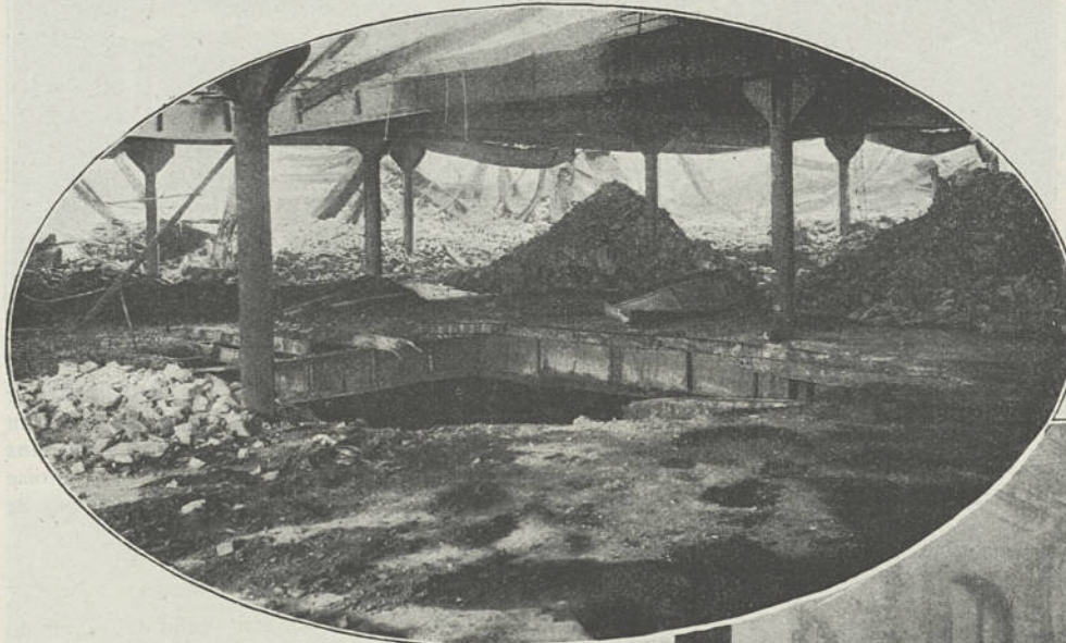
A gauche : Brèche ouverte par une torpille dans un plancher en ciment armé à l'Entrepôt des Laines.
