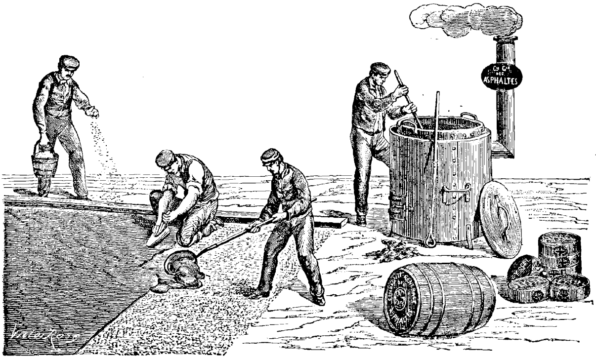
Fig. 284. — Ancienne chaudière pour l'application de l' asphalte coulé , et pavage d'un trottoir en asphalte coulé .
