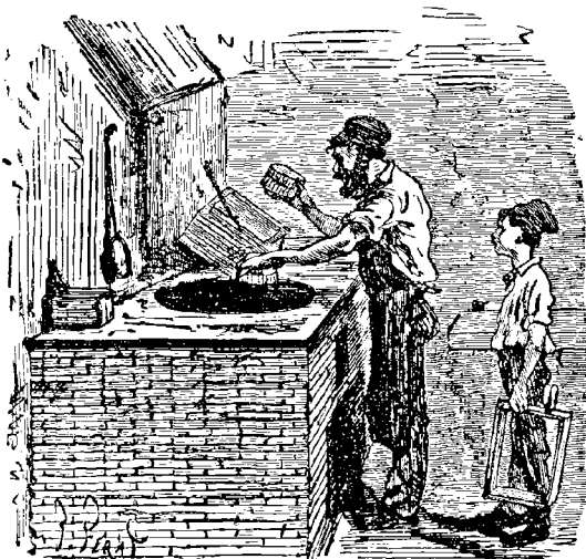
Fig. 249. — Soufrage des allumettes opéré à la main.
