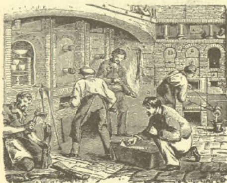
Fig. 375. — Chaufferie de fours à mouffles.
