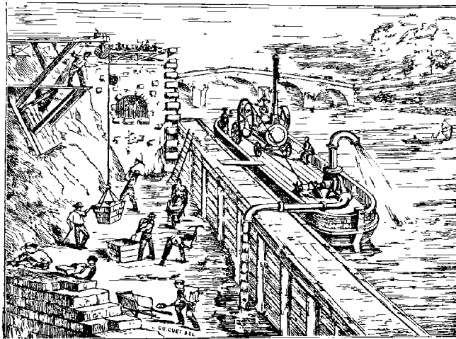
Pompe Dumont, pour travaux de fondation.
