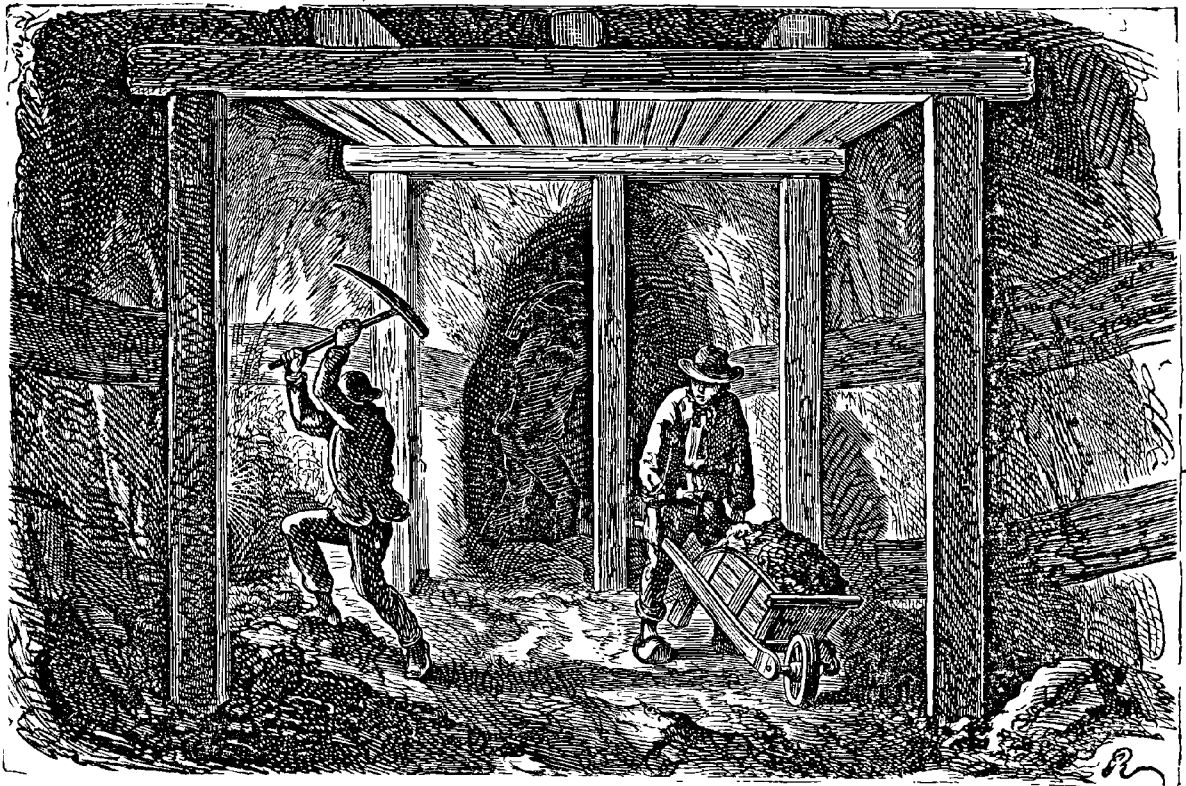
Perçement d'un tunnel à section totale (système anglais).
