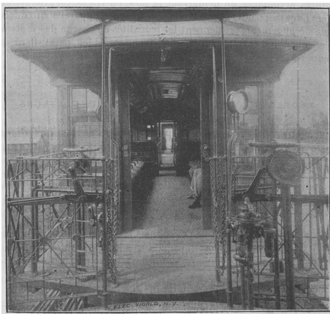
Fig. 672. — Vue d'un commutateur Sprague monté sur une plate-forme d'automobile.
