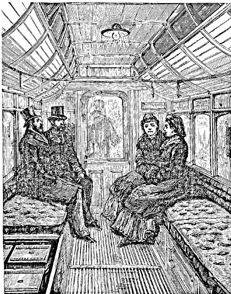
L'intérieur de la voiture, avec un des coussins enlevé pour laisser voir les accumulateurs.
