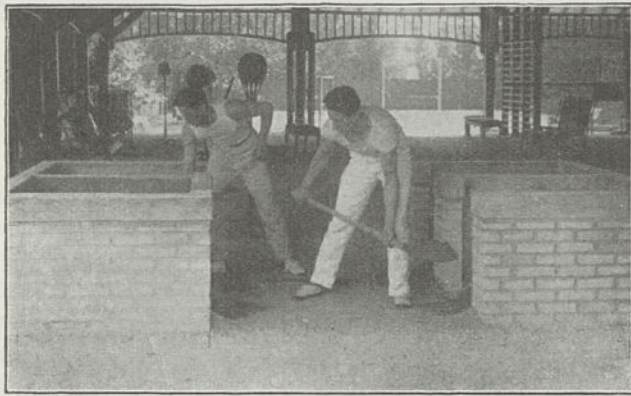
FIG. 73. — Exercice de terrassement.
