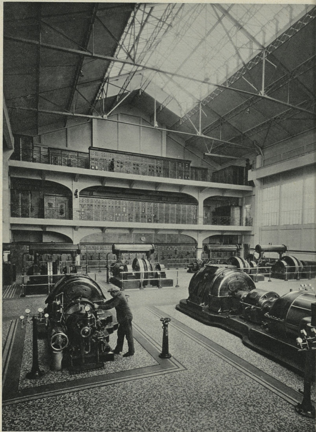
Centrale électrique de l'Usine Citroën des Epinettes. Salle des turbo-alternateurs. A l'arrière-plan les compresseurs, et au fond le tableau de distribution.
