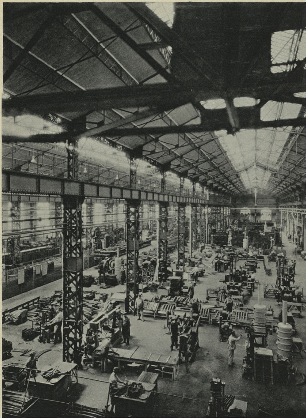
Usine Citroën de Clichy. Vue générale de l'atelier de fabrication des ressorts. Au premier plan, les machines de contrôle des ressorts terminés.
