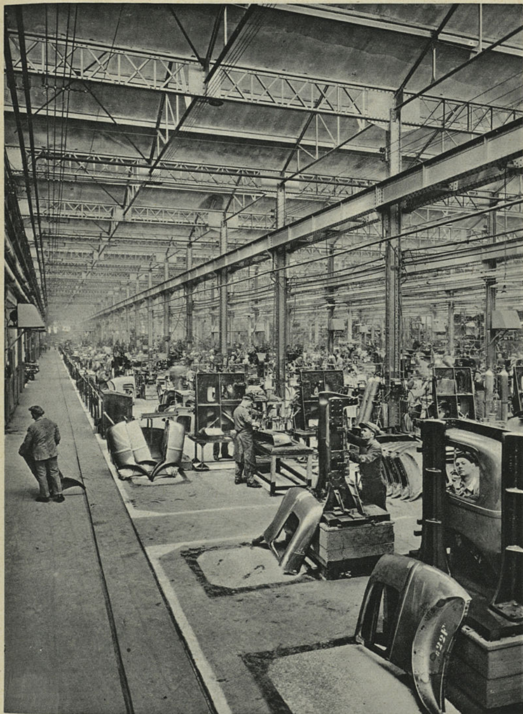
Usine Citroën de Saint-Ouen. Vue de l'atelier de montage des éléments de carrosserie par soudure des pièces embouties.
