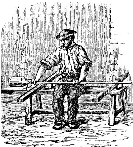
Fig. 84. — Fabrication d'une carafe. Le verrier assis sur son banc.
