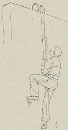
Fig. 510. — Perche dite Amorosiennne servant aux escalades et aux sauvetages.
