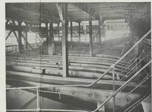
FIG. 28. — Mines de Courrières. — Criblage Standard. Vue d'ensemble des toiles de triage.
