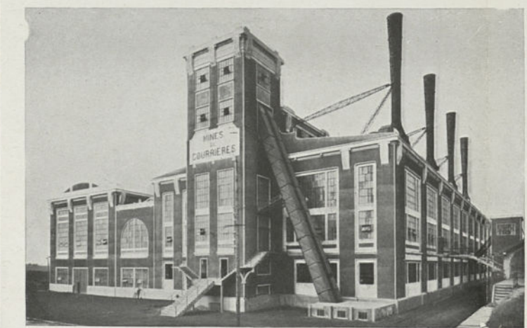
Fig. 3. — Mines de Courrières. — Façade principale de la centrale électrique.
