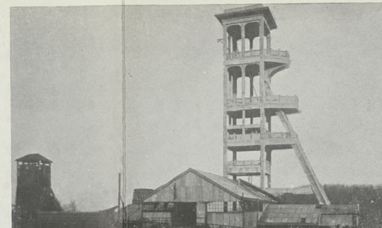
FIG. 37. — Mines d'Anzin. — Chevalement en béton armé de la fosse Saint-Mark.
