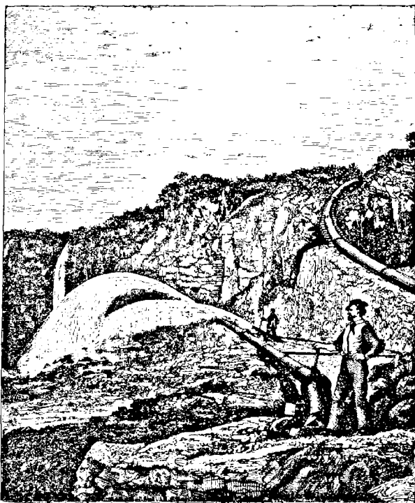
Fig. 36. — Mode de travail de la méthode hydraulique.
