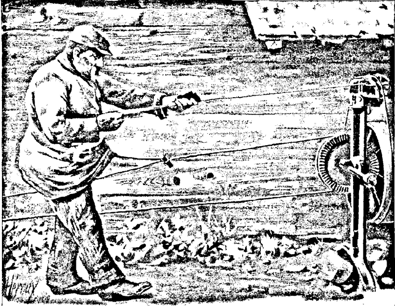
97. Seiler auf der Spinnbahn.
