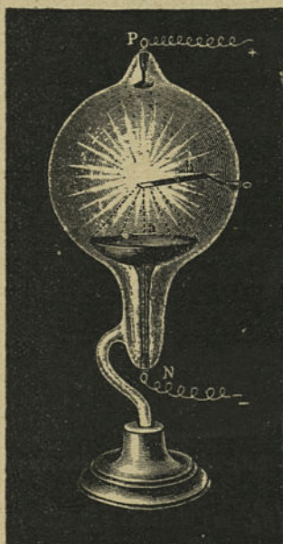
Fig. 10. — Dégagement de chaleur par les rayons cathodiques.
