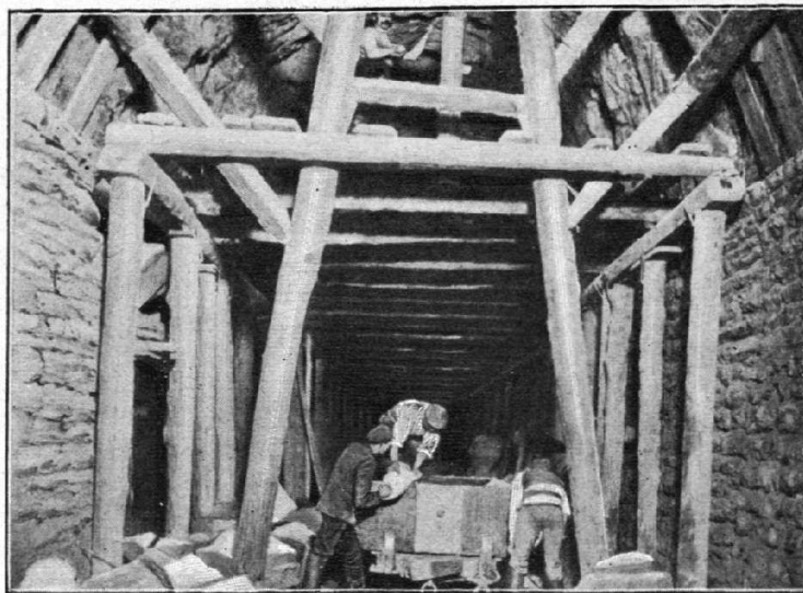
LE TRAVAIL DE SOUTÈNEMENT
