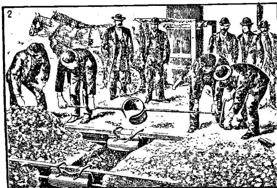
Fig. 67. — Soudure des rails à la fonte. — Opération du coulage.
