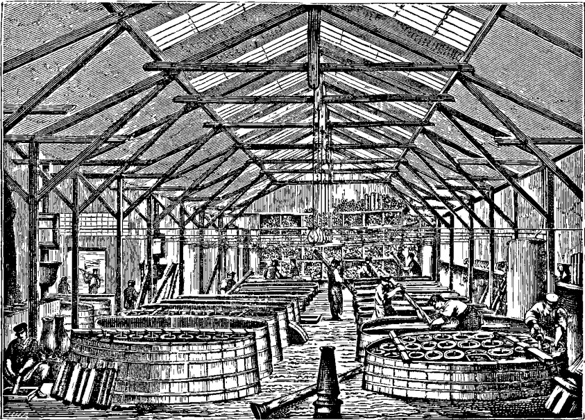
FIG. 423. — Atelier de cuivrage galvanoplastique de l'usine Oudry.
