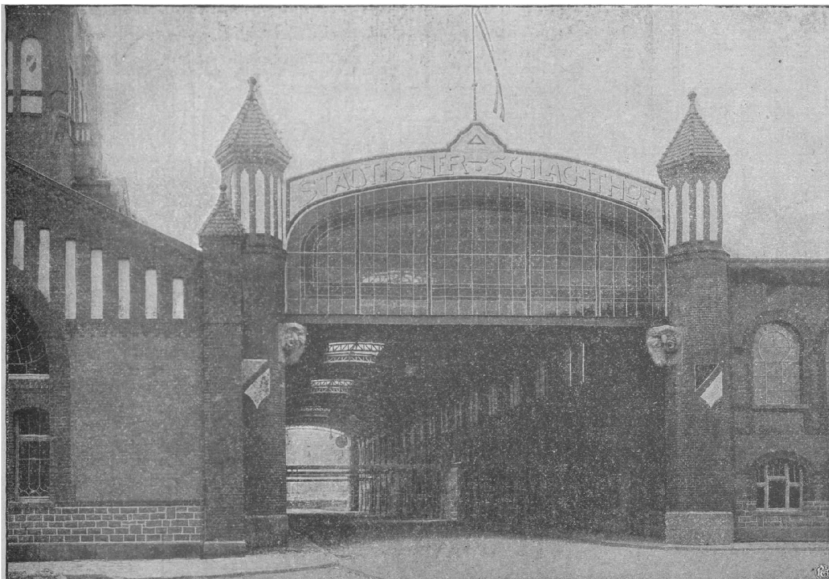
FIG. 331. — Hall d'intercommunication de l'abattoir d'Offenbach (Construction A. Borsig, de Berlin). Cliché A. Borsig.
