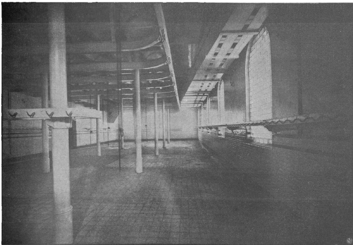
FIG. 361. — Antichambre froide pour le gros bétail ; installation de l'abattoir d'Offenbach (Construction A. Borsig de Berlin-Tegel) (Il convient de remarquer les grandes fenêtres placées à droite qui servent à l'éclairage de cette pièce au moyen de la lumière du jour).
