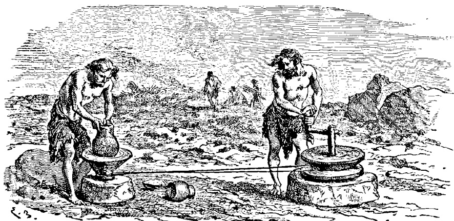
Tour à poterie.
