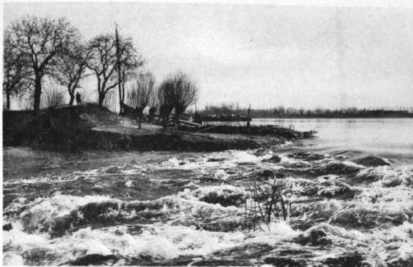
Phot. 68. Digue rompue du polder « Den Esch », à Tamise. — Avril 1907.
