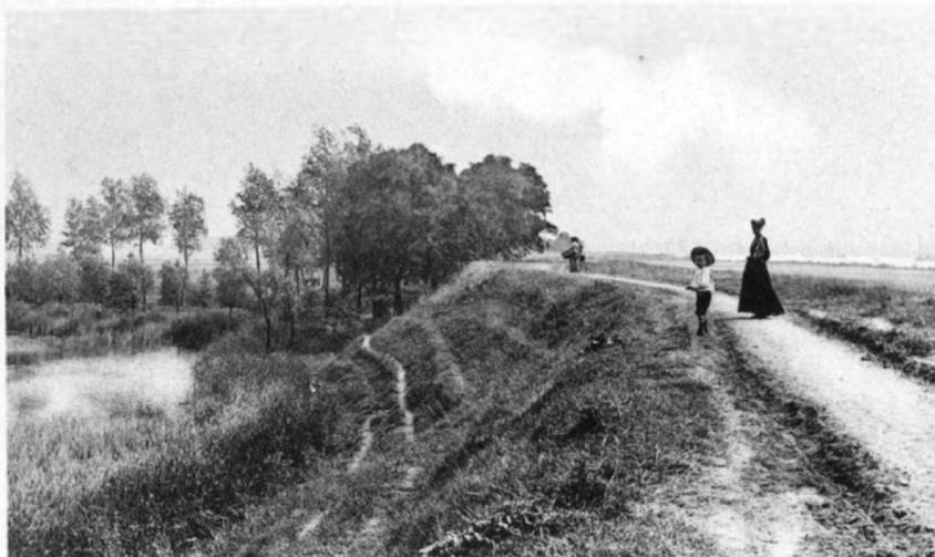
Phot. 65. Digue de l'Escaut, à Burght. — Juin 1904.
