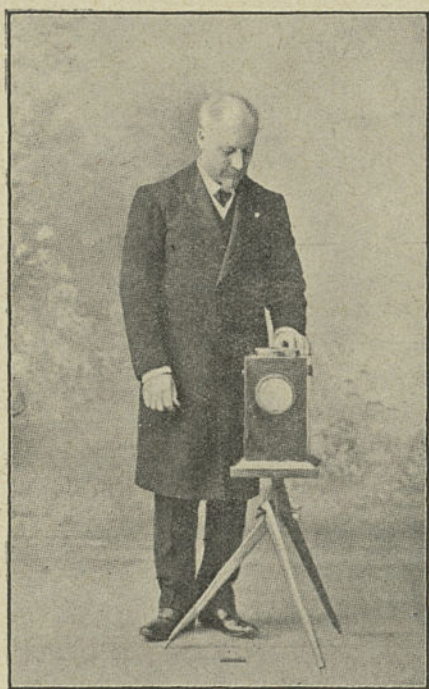
Fig. 47. — Procédés Géo-physiques pour la recherche des Eaux souterraines. — L'Indicateur galvanométrique des Eaux souterraines en mouvement de Henri Mager.
