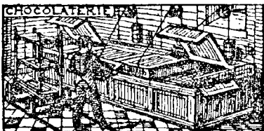
Refroidissement des Moulleurs à chocolat pour le démoulage instantané pendant l'Été.
