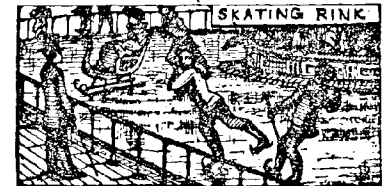
Congélation de l'Eau sur Parquets métalliques pour les Skating-Rink
