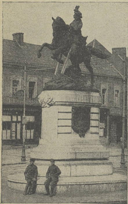
La Statue de Villars quelques jours avant sa destruction Le jarret du cheval a été scié : la Statue est retenue par deux étançons de bois
