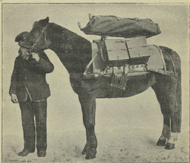
Fig. 50. — Mulet porteur de la dynamo et des accessoires.
