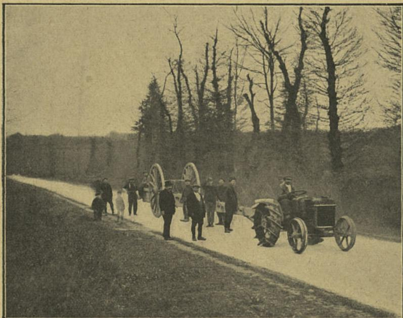
Fig. 294. — Poteau transporté sur route par triqueballe et tracteur agricole.
